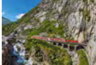
Deh 4/4 II 93 der Matterhorn Gotthardbahn, Schöllenen UR
