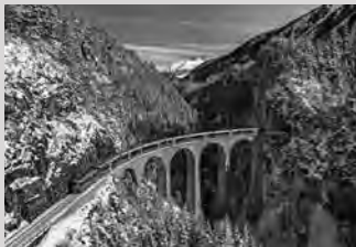
Landwasserviadukt, Filisur, Albulatal GR
