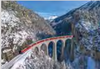
Landwasserviadukt, Filisur, Albulatal GR
